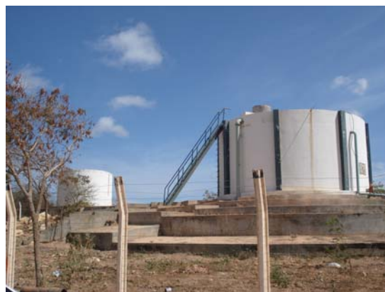
Figura 4.9: Reservatório Apoiado de 150 m 3 em Tanque Novo
