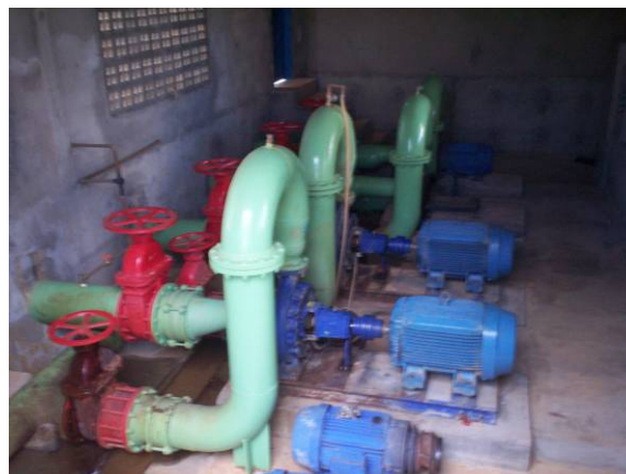
Figura 4.8: Detalhe dos conjuntos motobomba para lavagem dos filtros e bombeamento para distribuição.
