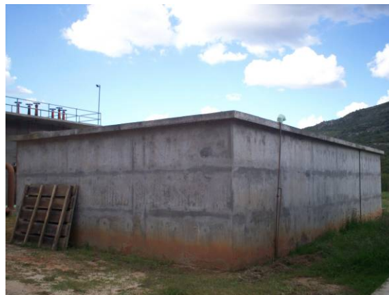
Figura 4.6: Reservatório apoiado (300m³) na ETA Paramirim
