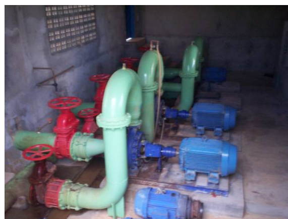
Figura 4.8: Detalhe dos conjuntos motor-bomba para lavagem dos filtros e bombeamento para distribuição
