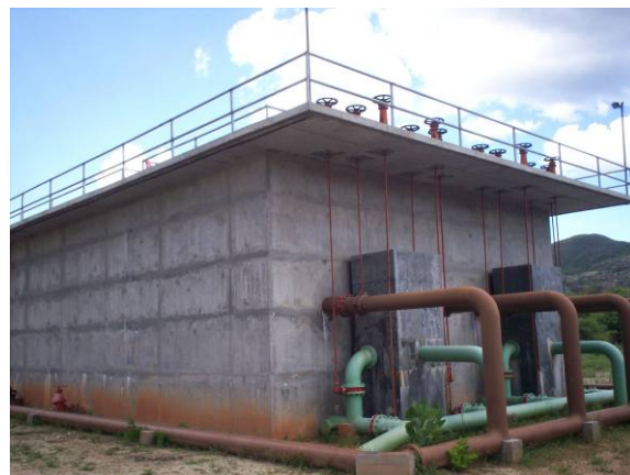
Figura 4.4: Detalhe do bloco hidráulico com floculação, decantação e filtração na ETA Paramirim
