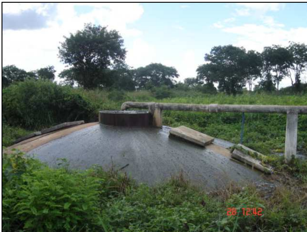
FOTO 5.4.5 – VISTA DO REATOR ANAERÓBIO DETALHE PARA O TRASBORDAMENTO DO ESGOTO PELAS PAREDES DO REATOR
