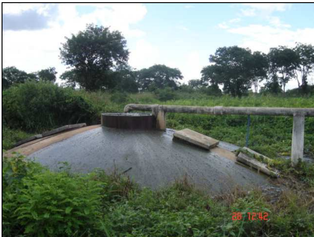
FOTO 2.5 – VISTA DO REATOR ANAERÓBIO DETALHE PARA O TRASBORDAMENTO DO ESGOTO PELAS PAREDES DO REATOR
