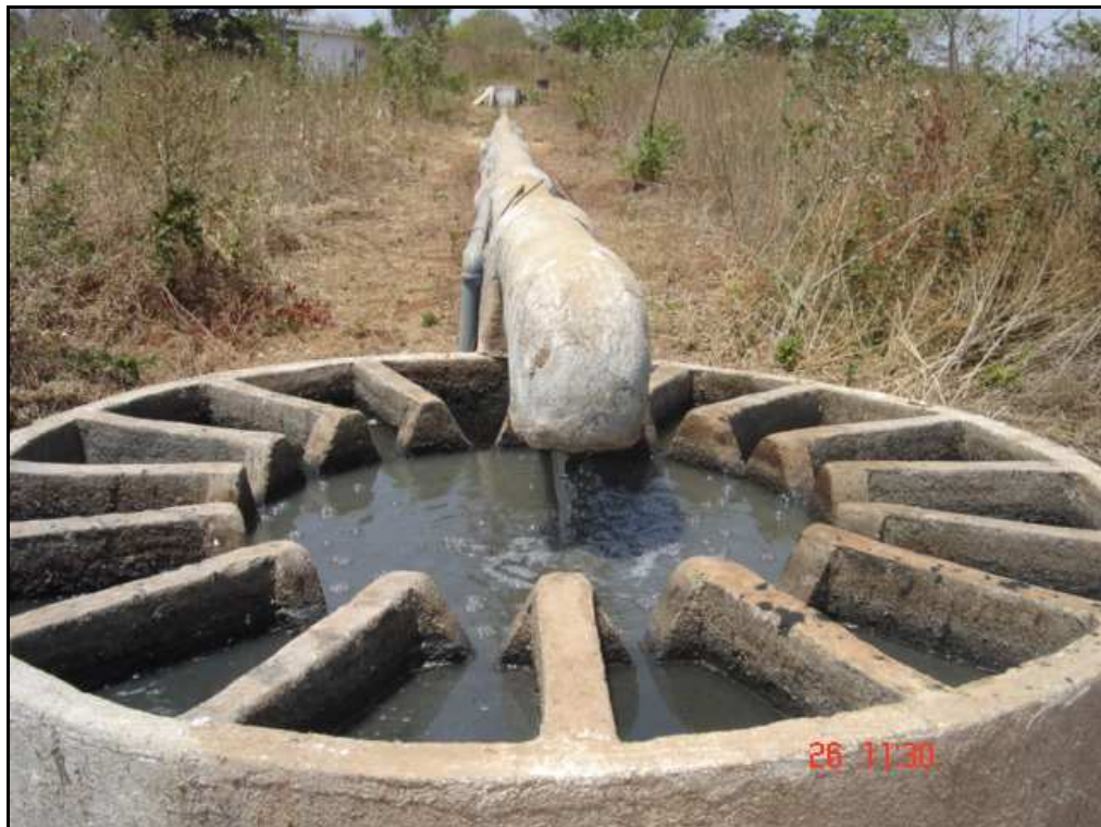
FOTO 3.2.4 - VISTA CAIXA DE DISTRIBUIÇÃO DE VAZÃO
