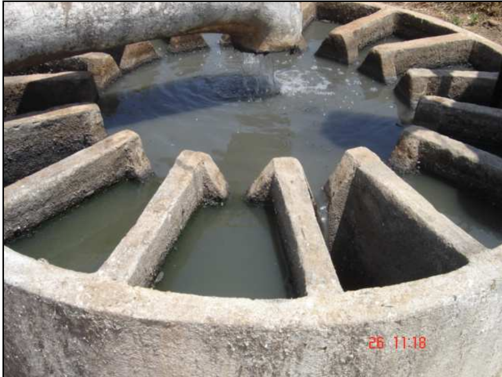
FOTO 3.2.5 – VISTA DA CAIXA DE DISTRIBUIÇÃO DE VAZÃO
